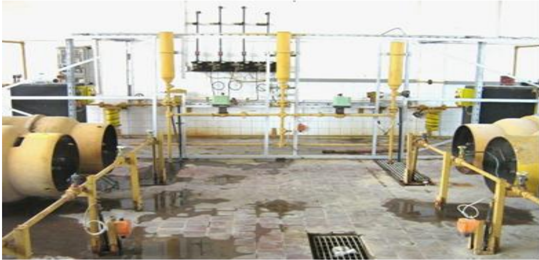
شكل (١) عنبر اسطوانات الكلور
