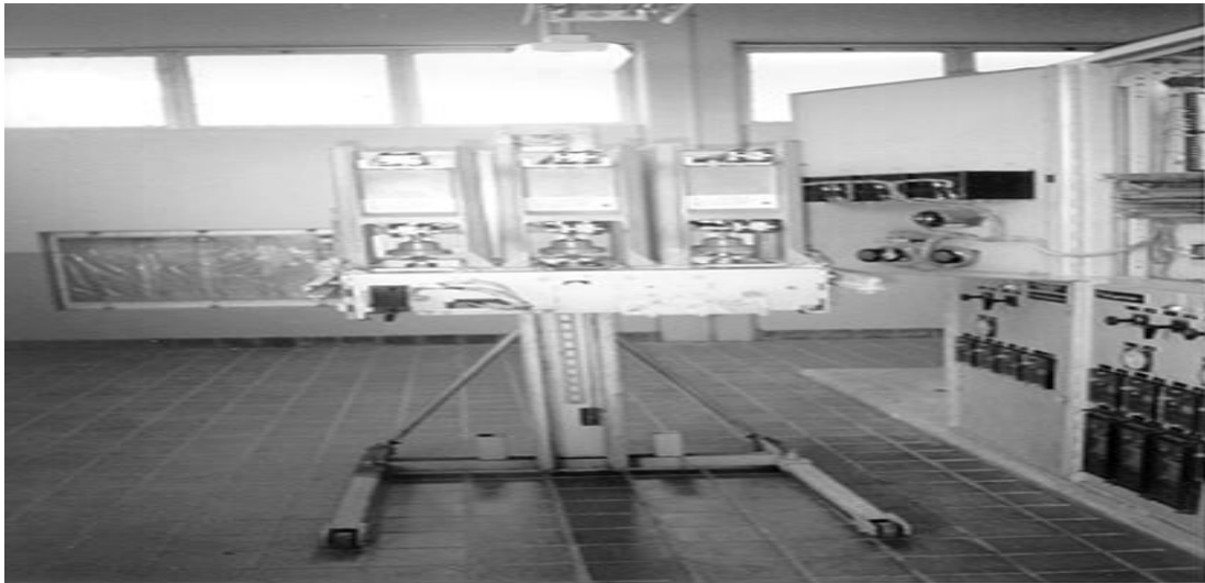
شكل رقم (٣-١) إخراج قاطع من كابينة باستخدام رافعة
