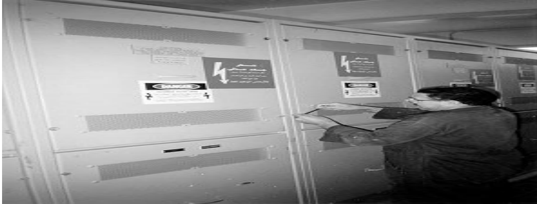
شكل رقم (٤-١) تثبيت الغطاء الواقي على فتحة الكابينة بالمسامير
