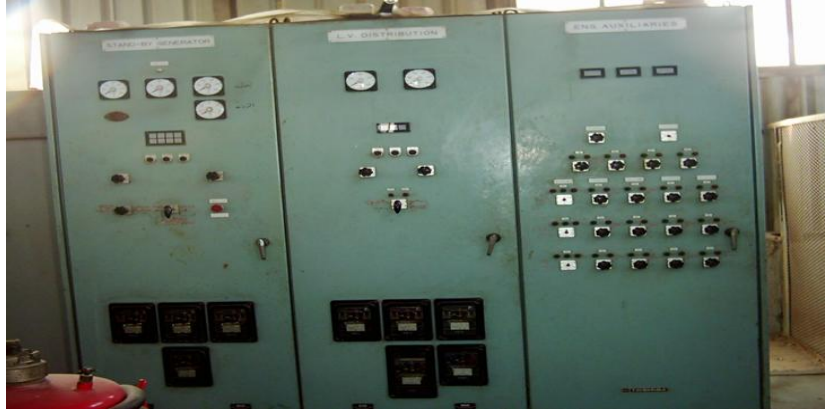
لوحة جهد منخفض تتغذى من مولد وتوزع التيار إلى الأقسام المختلفة
