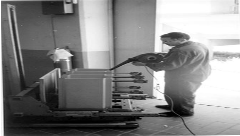
شكل رقم (٦-١) تنظيف قاطع تيار باستعمال هواء جاف مضغوط
