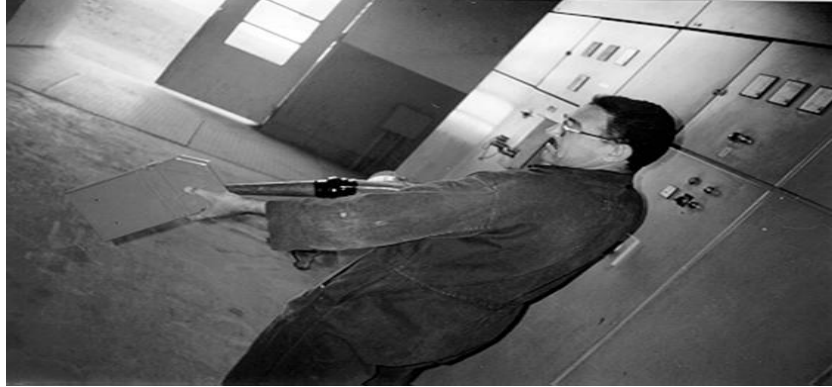
شكل رقم (٧-١) تنظيف غرف إخماد الأقوس بالهواء المضغوط
